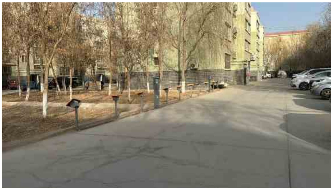
图：50 团现状电动自行车充电桩
