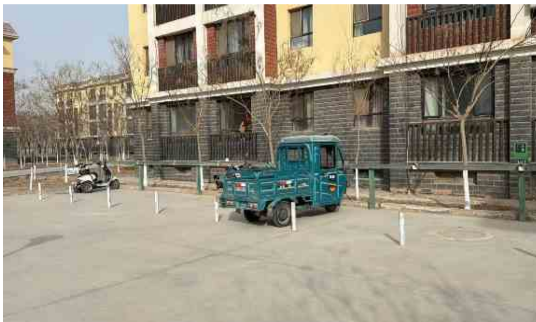
图：现状已无法使用的电动自行车充电桩 表：53 团既有小区电动自行车充电桩情况
