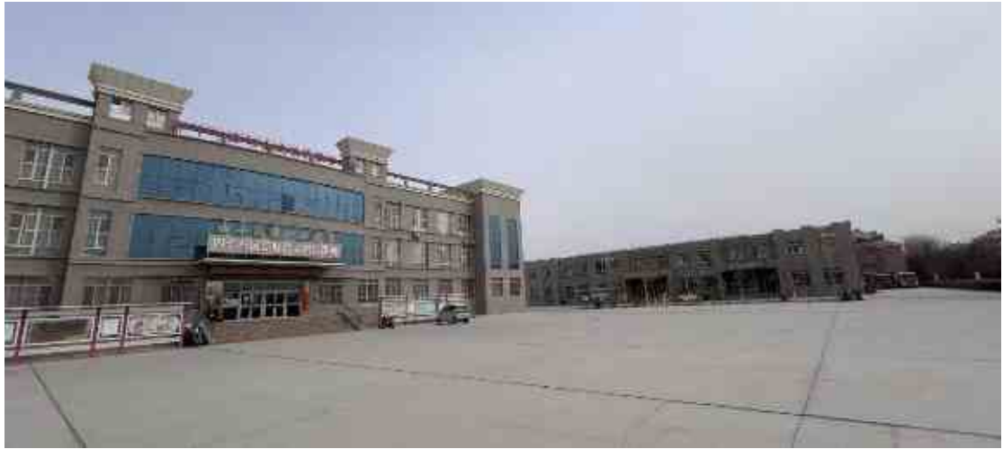
图 48 团便民服务中心大楼前广场现状
